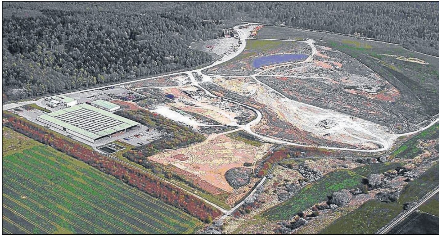
Soll irgendwann wieder Natur werden: die Mülldeponie Kirschenplantage in Hofgeismar. 200 000 Kubikmeter Verfüllvolumen sind noch vorhanden, aktuell werden dort pro Jahr nur 8000 Tonnen mineralischer Müll deponiert. Foto:nh
